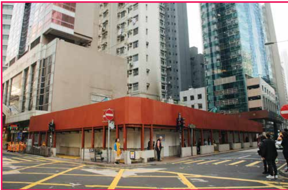
伊榮街的J Plus酒店原址已成為地盤，疑改建為銀座式商廈。
