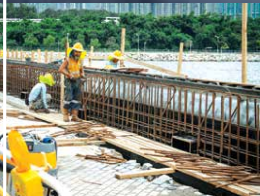
原先的不鏽鋼欄杆改成堅固的擋浪牆。
