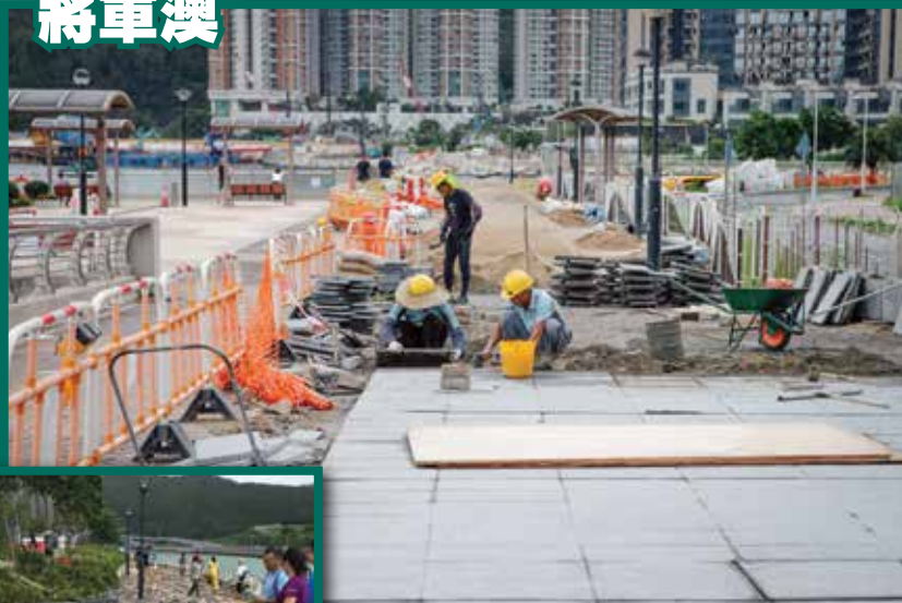
將軍澳海濱長廊工人正加緊鋪地磚。
