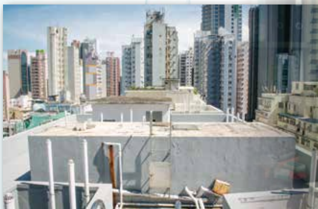
全港數以萬計樓宇，天台都設有水箱供水，但目前法例並無強制要求定期清潔。
