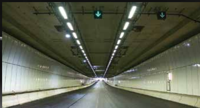
過海隧道內的工程大致完成。
