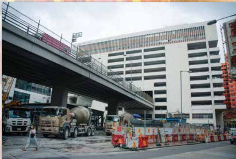
油麻地多層停車場周圍已變成地盤。
