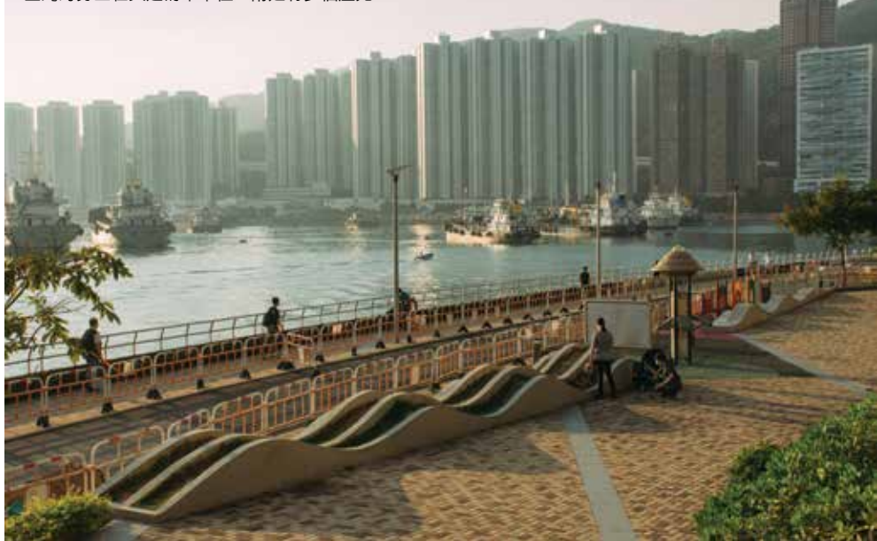
荃灣海旁正在興建的單車徑，附近有多個屋苑。
